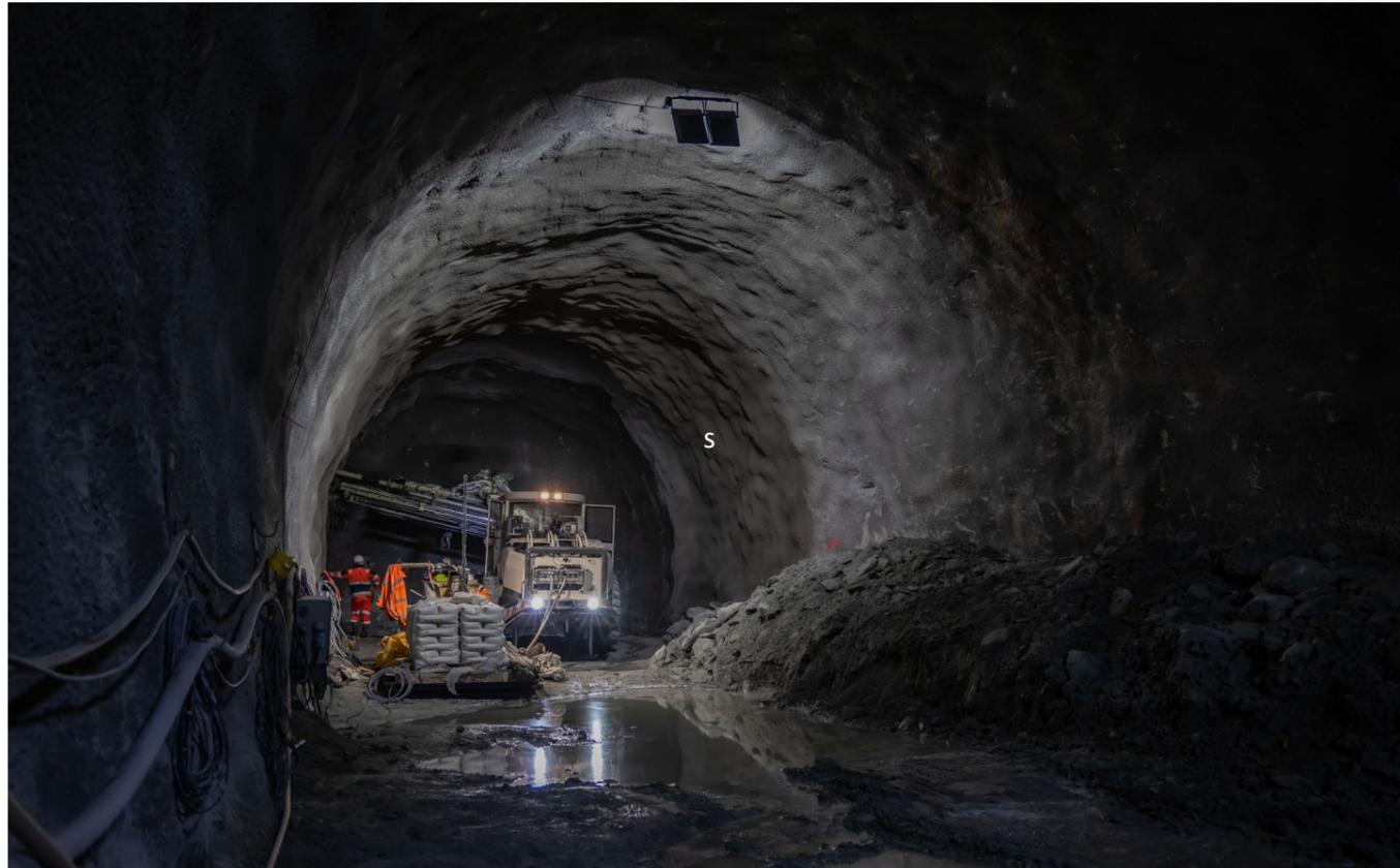
Boulonnage de la voûte au niveau du front d'avancement de la galerie de connexion
