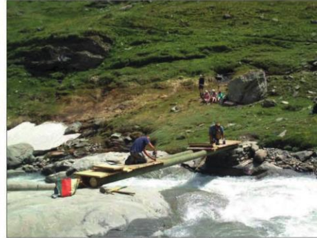
Le service activités de pleine nature de la CCHMV prépare déjà la saison estivale et la réouverture des sentiers. Ici, la réfection d'une passerelle. Photo DR
