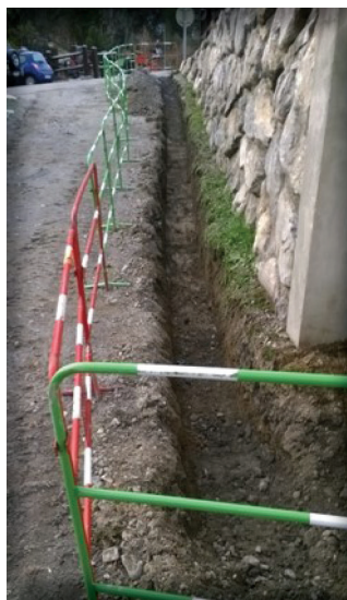
Travaux pour l'arrivée de la fibre
